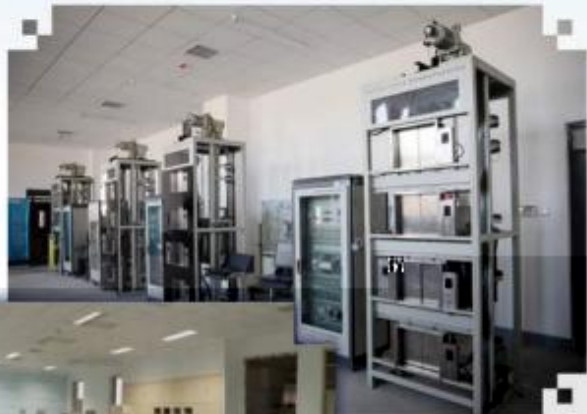
智能电梯安装调试 维护训练场所
